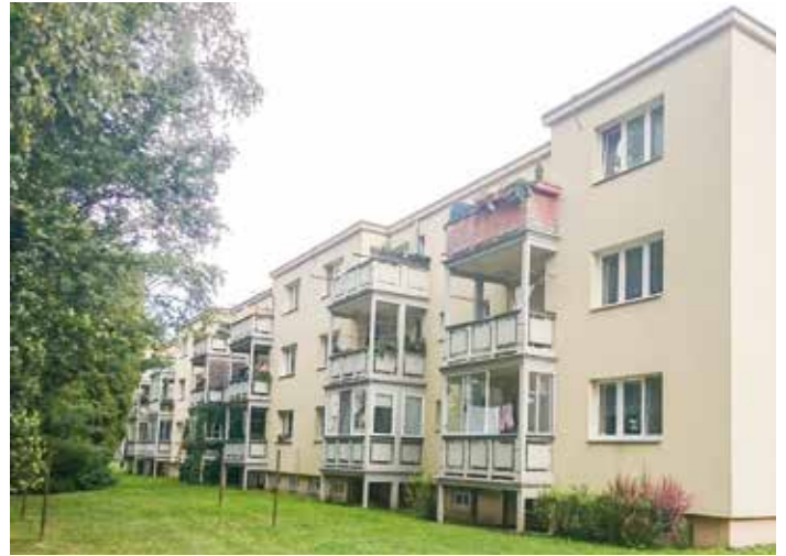
První bytový dům postavený z panelů na Podvesné podle návrhu architekta Miroslava Drofý Foto | Pavel Stojar
