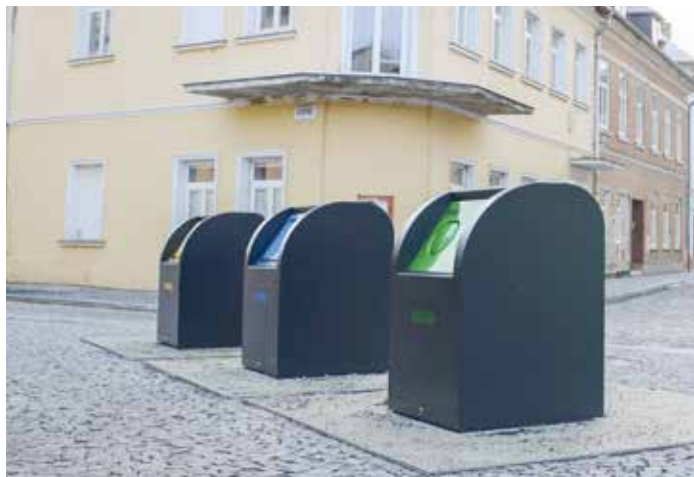
Vhazovací sloupky podzemních kontejnerů na ulici ve Šternberku
