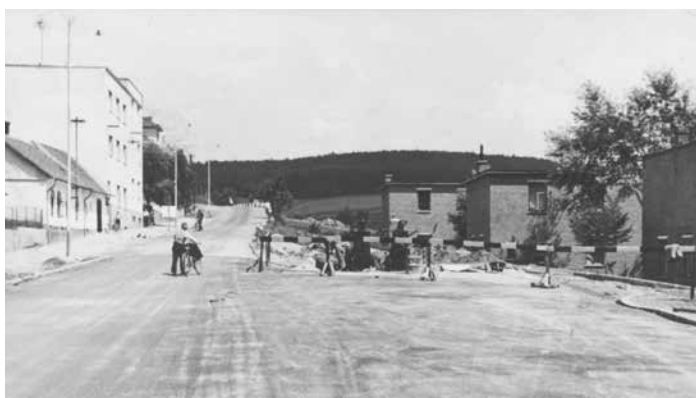
V roce 1933 se začalo na konci Sokolské třídy s výstavbou nové silnice směrem k Fryštáckému potoku.
