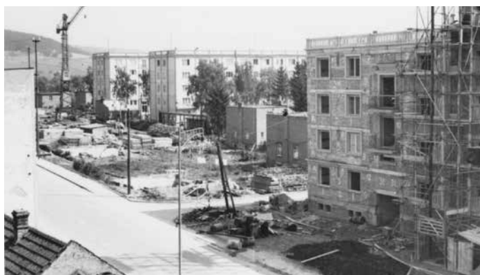
Půldomky na Padělkách začaly ustupovat bytovým domům v 50. letech. Zdroj | 2x SOKA Zlín
