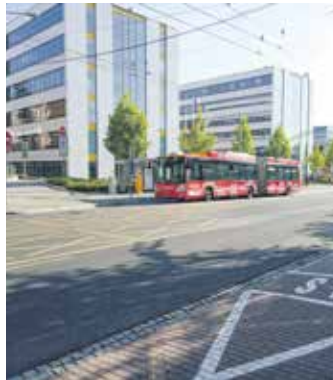
Oprava vozovky u zastávky Školní přijde na řadu mezi 6. a 12. srpnem. Foto | Marek Adamík
